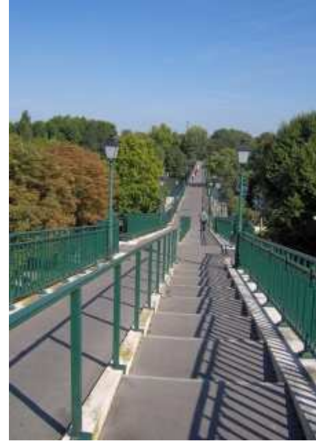
Passerelle de l'Avre
