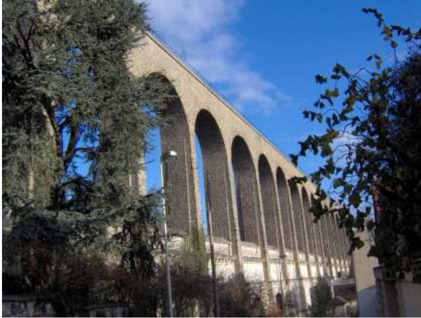
Les ponts-aqueducs d'Arcueil
